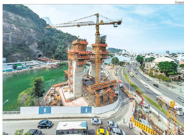
Construção da Ponte estaiada na Barra da Tijuca – Linha 4 do Metrô RJ
