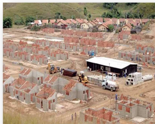
Obras realizadas pela CEHAB
