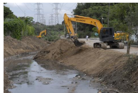
Obras de recuperação ambiental na Bacia do Rio Imboçu
