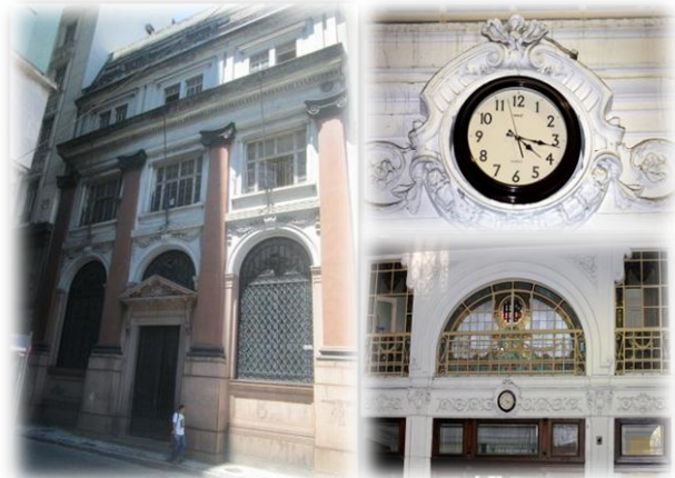
Figura 12: Fotos da fachada da Nova Sede da EFAZ, na Rua da Quitanda, 29
