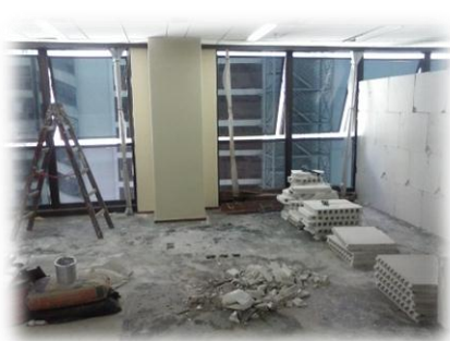
Figura 11: Obra no novo endereço
