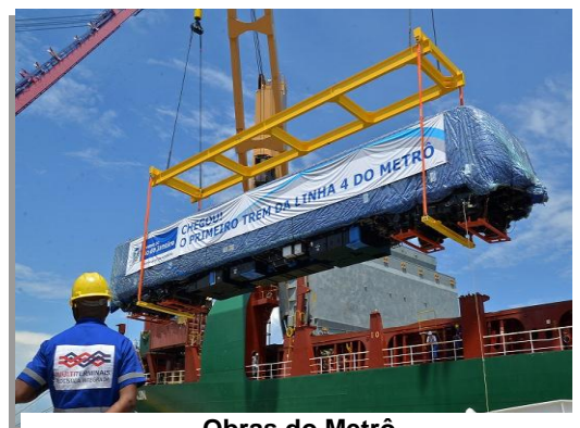
Obras do Metrô
