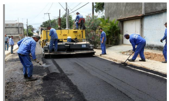
Obras do Asfalto na Porta/Bairro Novo
